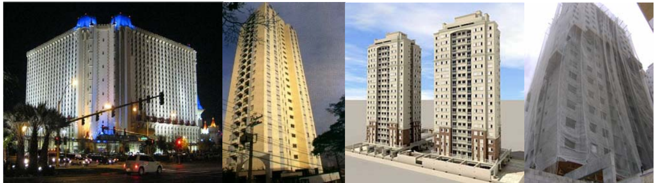
(A) (B) (C) (D) FIGURA 2.12 - EXEMPLOS DE EDIFÍCIOS CONSTRUÍDOS COM ALVENARIA ESTRUTURAL DE BLOCOS DE CONCRETO
