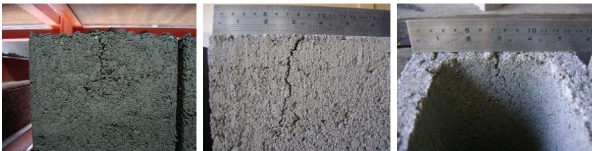
FIGURA 3.21 - TRINCAS EM BLOCOS DEVIDO A VELOCIDADE DE DESFORMA
