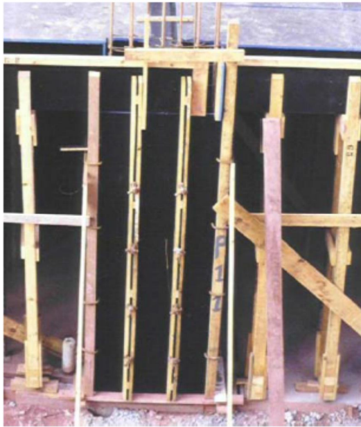
FIGURA 14 - EXEMPLO DE MOLDE E ESTRUTURA DO MOLDE DE PILAR FONTE: MORIKAWA (2003)
